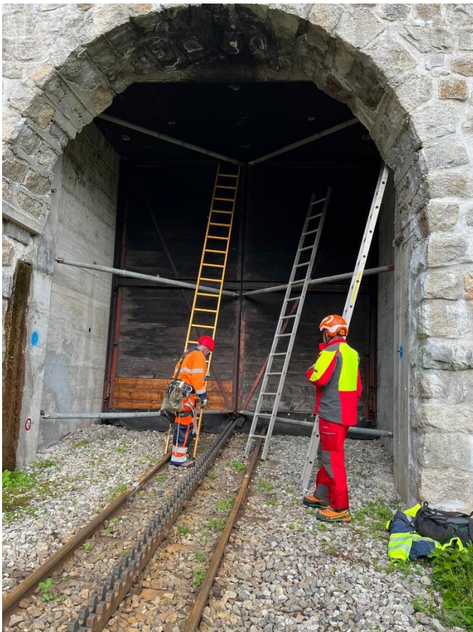
Fritz Gerber und Beat Suter beginnen mit der Demontage der Spriessse des talseitigen Tors des Tunnels 1. Foto: Karlheinz Felder.
