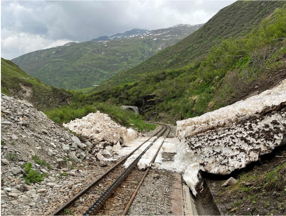
Die Räumstelle zwischen Tunnel 2 und Tunnel 1. Foto: Patrick Smit.
