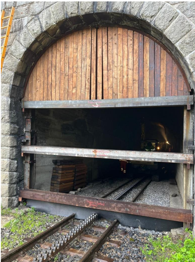
Demontage des bergseitigen Tors des Tunnels 3. Foto: Karlheinz Felder.
