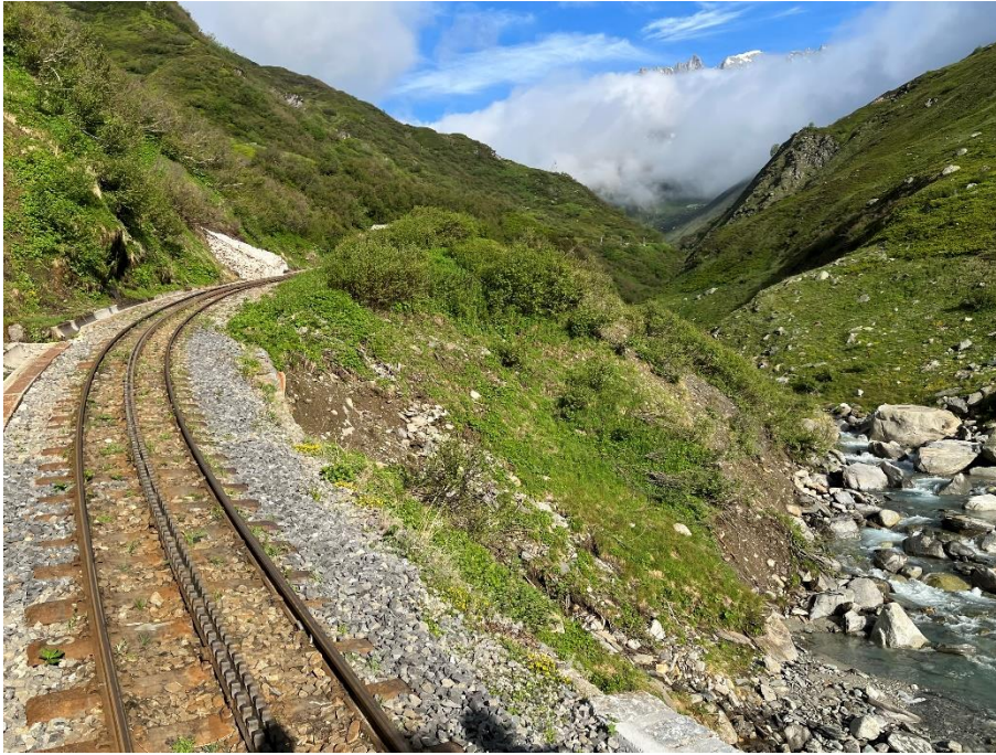
Zwischen Tunnel 2 und Tunnel 1. Der Galenstock lugt aus der Wolken- decke.
