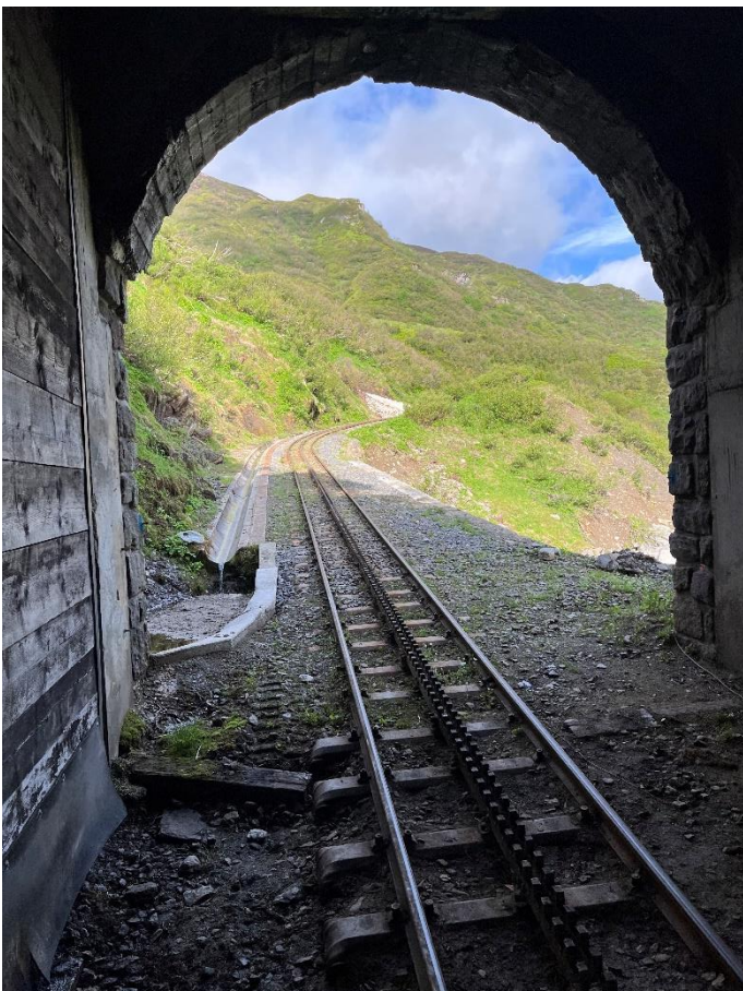
Blick aus dem bergseitigen Portal des Tunnels 2 während der Fahrt zur Station Furka am Donnerstagmorgen.
