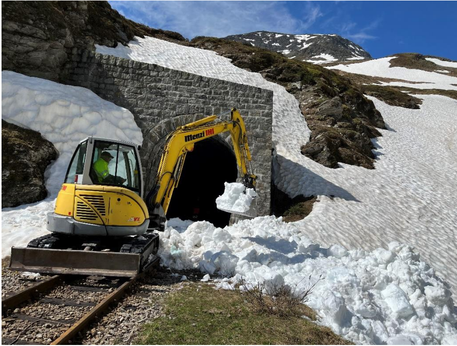
Alexander Briner räumt den Restschnee beim Ostportal des Scheiteltunnels.
