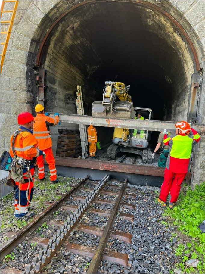
Demontage der Stahlträger des bergseitigen Tors des Tunnels 3.
