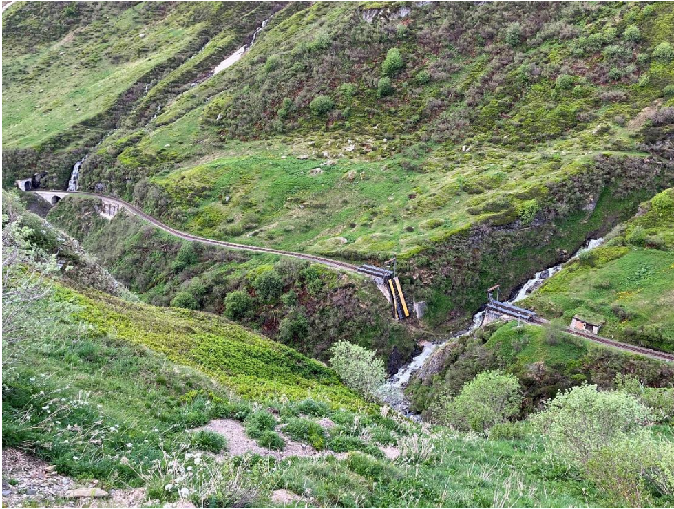
Blick von der Rufikehrstrasse zum Tunnel 1 und Steffenbachbrücke. Foto: Patrick Smit.
