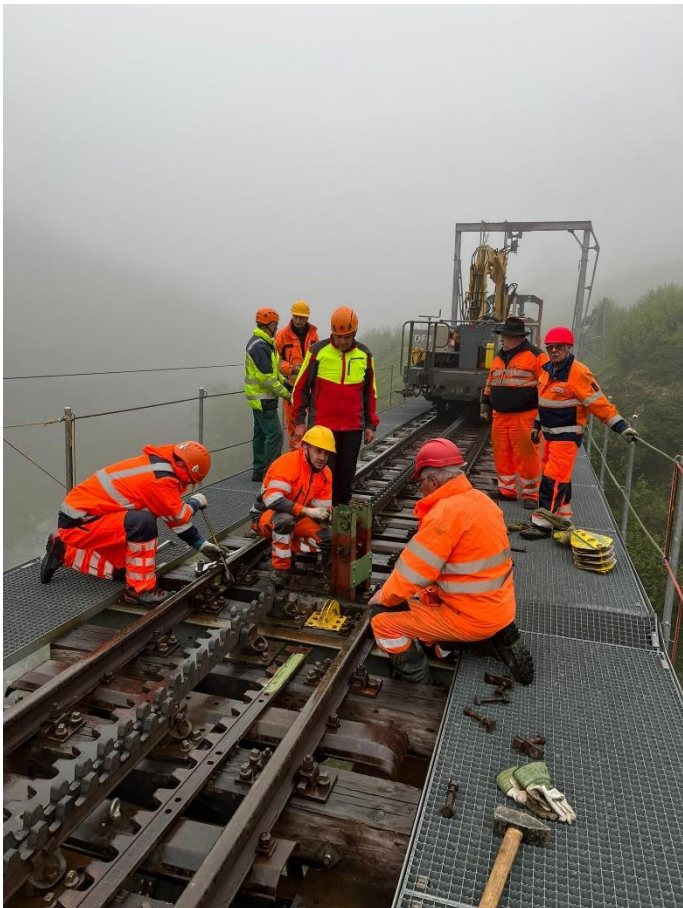
Die letzten Laschen und Zahnstangenlamellen zwischen dem bergseitigen und mittleren Brückenelement werden verschraubt. Foto: Karlheinz Felder.
