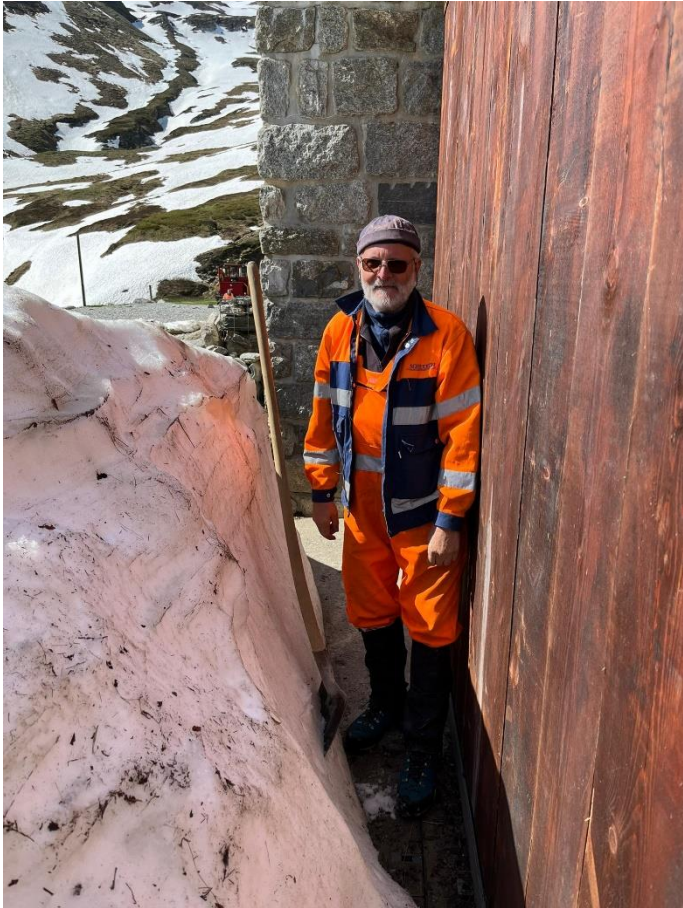
Marcel Oulevay demontiert die Holzabdeckungen der Toiletten der Station Furka. Foto: Karlheinz Felder.
