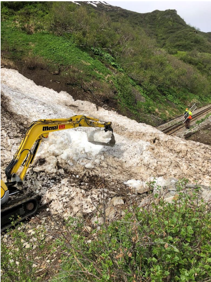
Alexander Briner räumt den Rest des «obligaten» Lawinenkegels zwischen Tunnel 2 und Tunnel 1 vom Bahntrasse weg.
