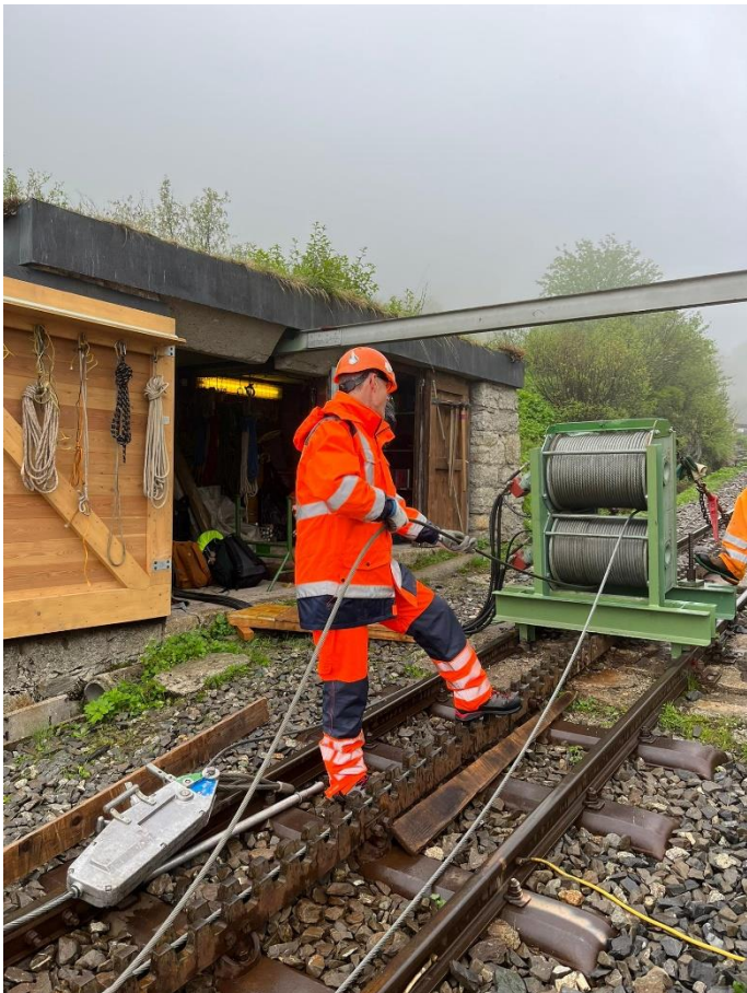
Reto Alber überwacht das Abspulen des Drahtseils von der unteren Seilrolle beim Windenhaus. Foto: Karlheinz Felder.
