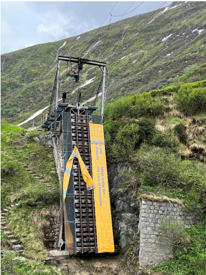
Einziehen der Drahtseile für den Vershub des talseitigen Brückenelements in die Sommerstellung. Foto: Patrick Smit.
