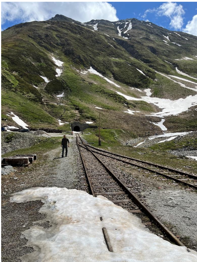
Nachdem Michael Bühler, Markus Grünenfelder und Patrick Smit die Tore beim Ost- und Westportal des Scheiteltunnels geöffnet haben, schauen sie sich bei der Station Muttbach-Belvédère um. Vor knapp zwei Wochen lagen hier noch bis zu 1,5 m Schnee.
