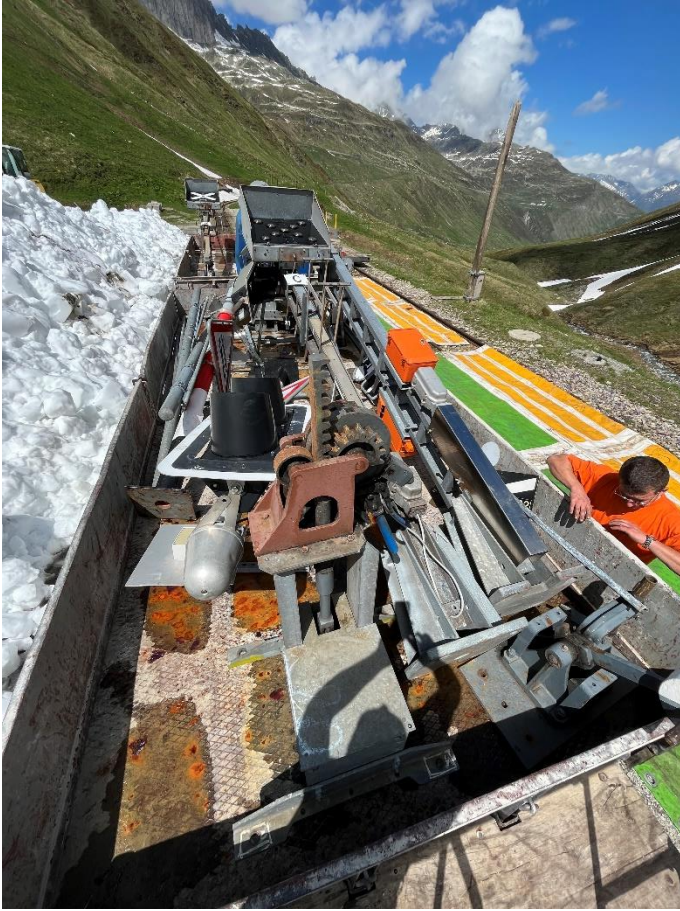
Michael Bühler hat die Schutzblachen der Weicherböcke und Signale entfernt.
