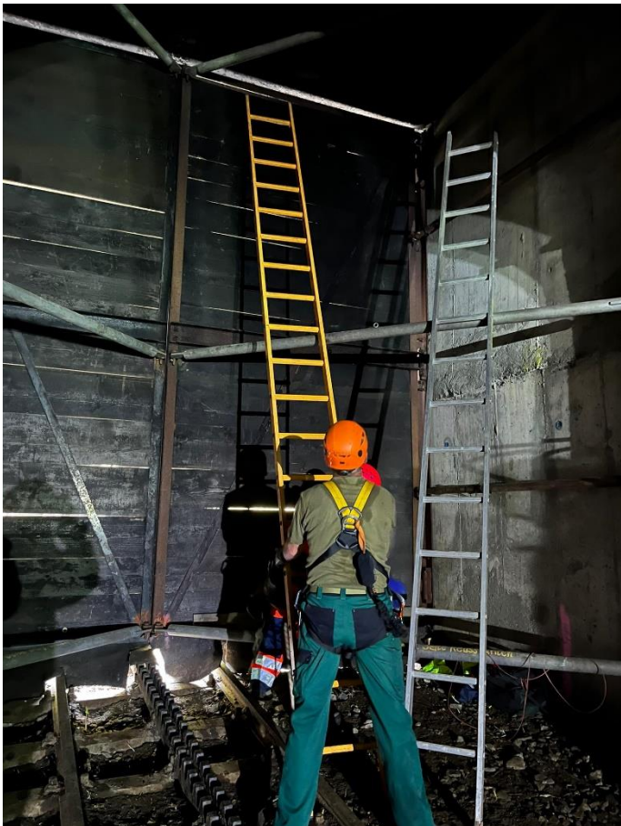
Christoph Spinnler bereitet die Demontage der Spriesse des bergseitigen Tors des Tunnels 1 vor.
