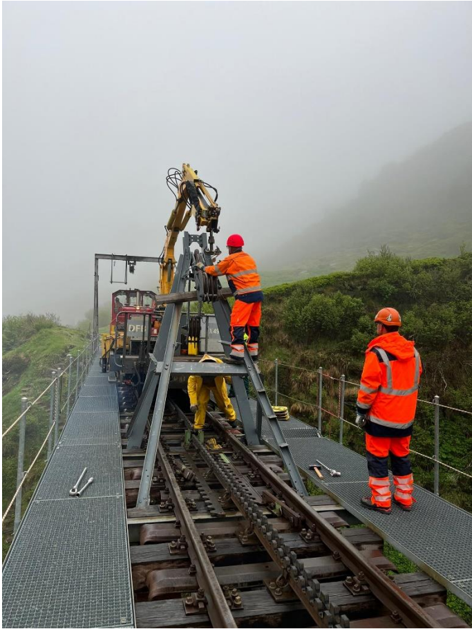
Demontage des Umlenkebocks mit dem Kranwagen. Foto: Karlheinz Felder.
