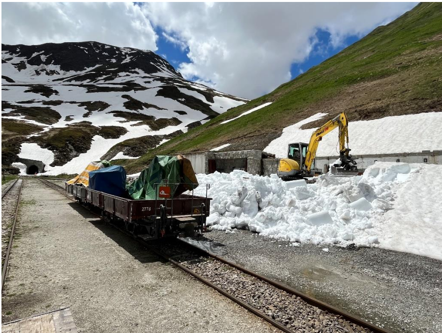
Alexander Briner räumt den Schnee vom Stationsgebäude der Station Furka weg. Auf Gleis 1 stehen die beiden Tiefbordwagen mit den Weichenböcken und Signalen der Stationen Furka und Muttbach-Bevlvédère sowie des Bahnübergangs Furkastrasse. Die Wagen waren während der Winterpause im Scheiteltunnel abgestellt. Foto: Patrick Smit.
