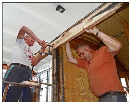
Einsetzen eines Teiles des Dachbalkens
