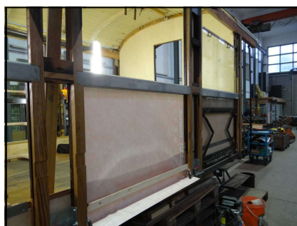
Kunststofffolien führen Wasser aus dem Fensterbereich nach aussen
