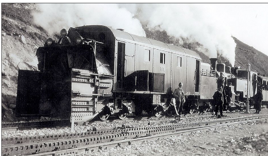
Probefahrt der RhB-Schneesleuder R12 im Eröffnungsjahr der Furka-Oberalp-Bahn am Oberalppass (Kreuzungsstelle Tschamut-Selva 1926 / Foto: FO-Archiv)
