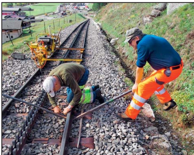
Eisenbahn-Schwerarbeit beim Ausnivellieren der Gleise
