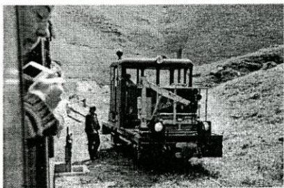
Maschineller Fröni der DFB AG auf dem Stumpengleis im Bahnhof Muttbach-Belvédère (DE)
