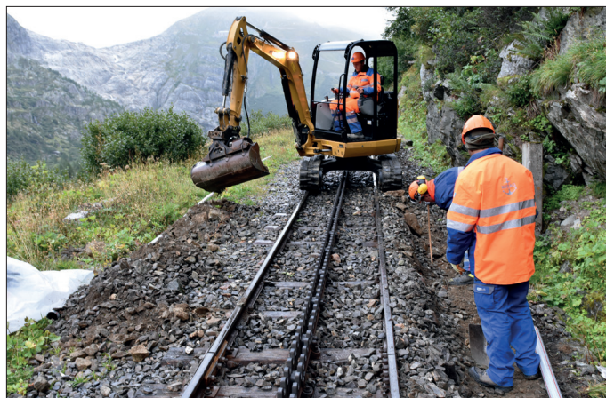
Die Gleissanierung zwischen Gletsch und Muttbach-Belvédère wird 2025 weitergeführt (Bild vom 10. Sept. 2019).
