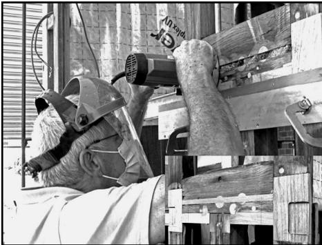
Das einmal in den Seitenwänden eingedrungene Wasser ist zudem in der Glaswolleisolation gespeichert worden und hat dort besonders lange sein zerstörerisches Werk verrichtet. Eine bekannte Schwachstelle ist in der halben Höhe (Fenstersims) der Fensterpfosten
