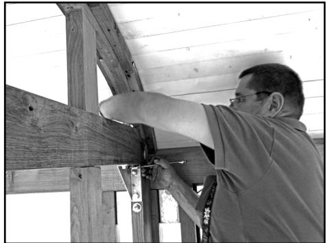
In den darauffolgenden Wochen wurden die Verstärkungs-Blechwinkel eingefügt und Schraube für Schraube montiert. Mit gezielter Hilfe von Spannssets und leichten Schlägen mit dem Gummihammer fügten sich auch die letzten Lücken ganz zusammen. Der freigewordene Platz in der Montagehalle dient uns nun für die Arbeitsvorbereitung am AB 4421.
