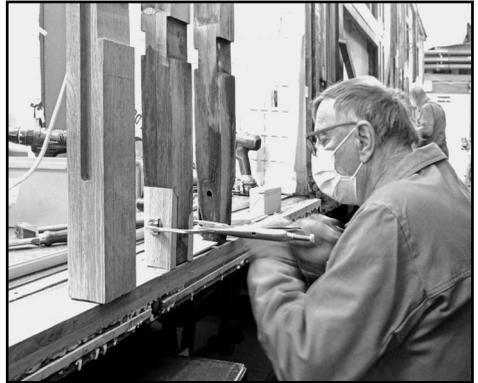
*Die unteren Enden der Fensterpfosten sind Schwachpunkte betreffend Feuchte:* Das beim Fenster eindringende Wasser sucht sich seinen Weg hinter die Fenstertraversen und in die Tiefen der Zapfenverbindungen. Diese Stelle im Fensterpfosten ist konstruktionsbedingt an sich schon schwach.
